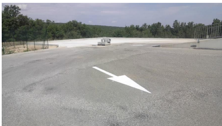
Vue sur l'aire dédiée aux déchets verts
