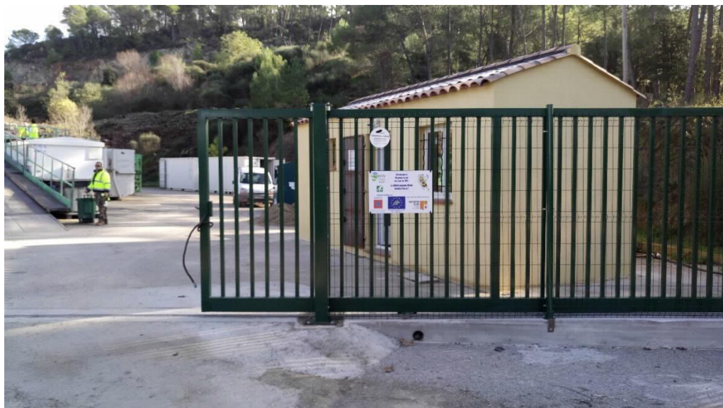
Vue sur l'entrée après opération de réhabilitation
